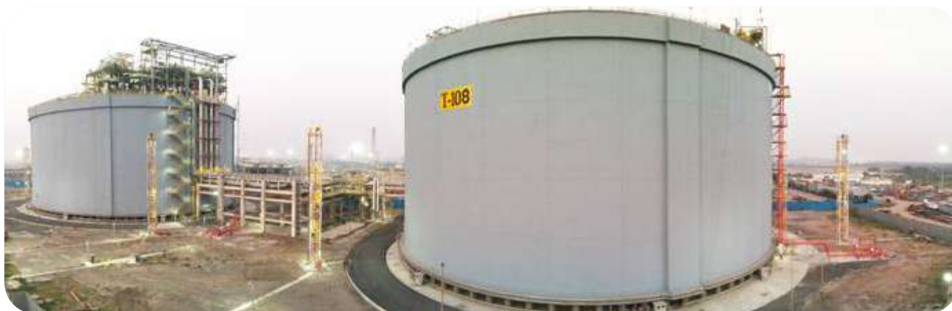
LNG Storage Tanks at LNG Terminal in Dahej
