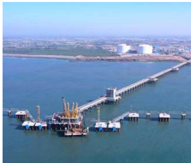
Chhara LNG Terminal
